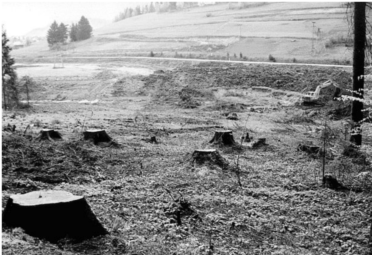
Drogę S-69 już modernizują. Fot. Rafał Kurek
