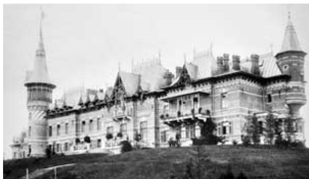
Pałac carski od strony południowej. Karcov 1903
