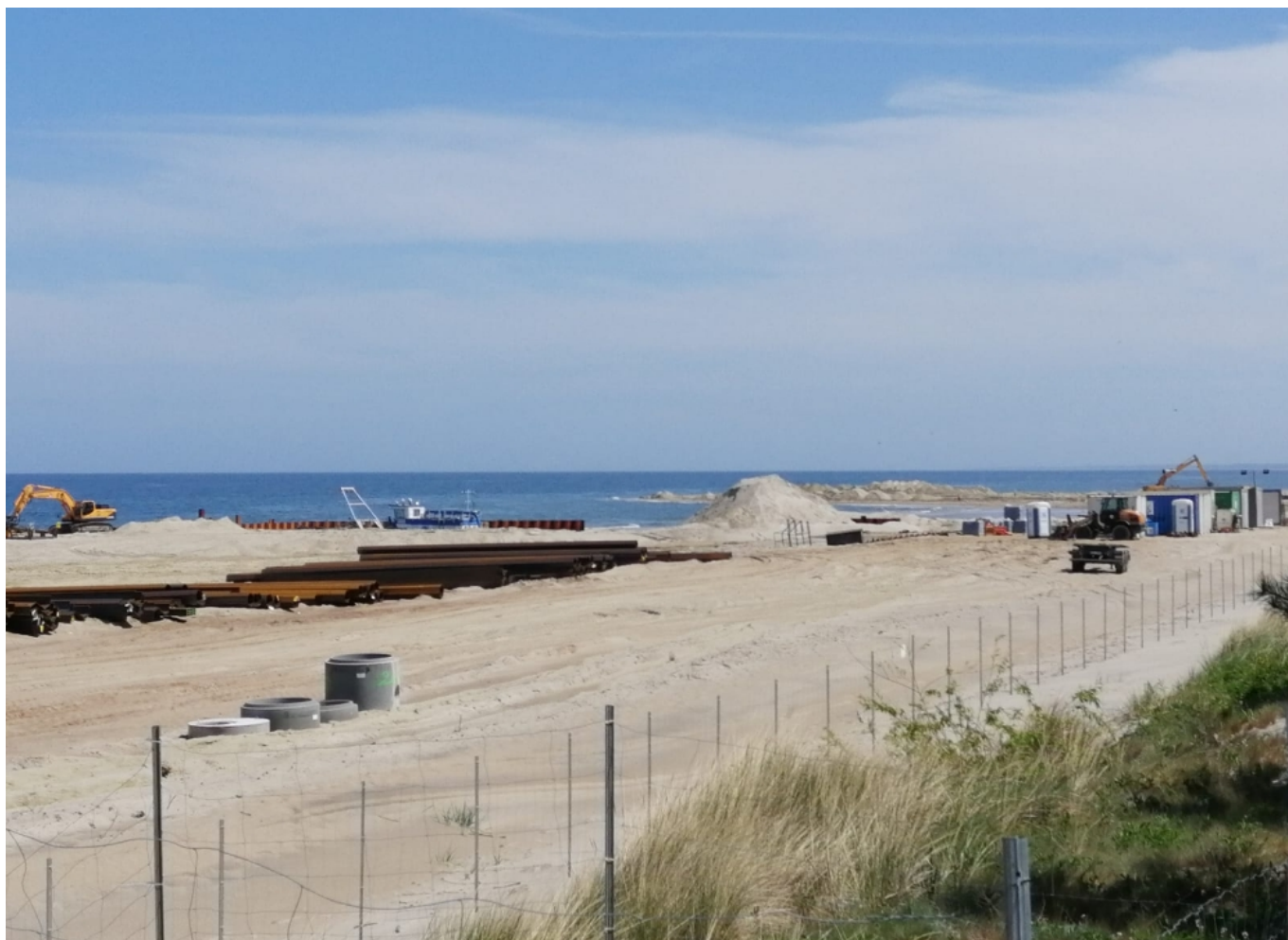
Budowa portu osłonowego od strony Zatoki Gdańskiej. Fot. Obóz dla Mierzei Wiślanej
